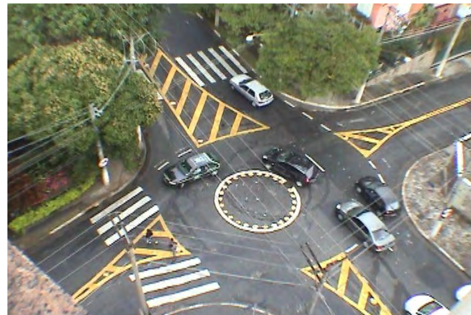
Fotografia: Minirrotatória em sua configuração final
