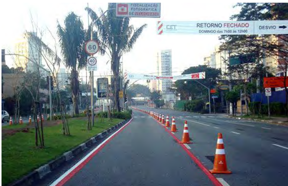
Fotografia: Ciclofaixa já instalada, antes do início da operação
