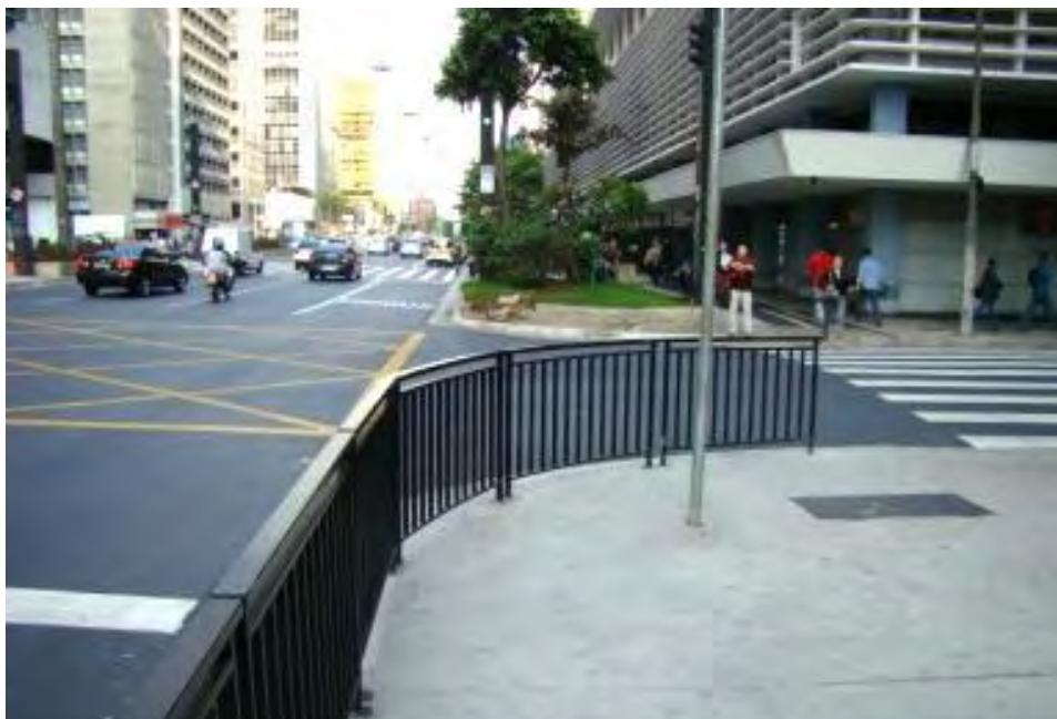
Fotografia: Vista de gradil implantado em cruzamento
